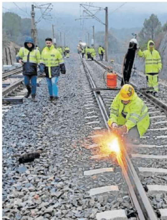
Varios operarios en las obras de reparación de Adamuz, el 30 de enero, en una imagen del Ministerio de Transportes.
